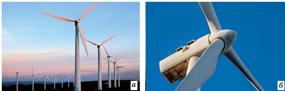
Мал. 38.8. Вітрова електростанція
