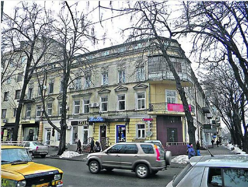
Жилий будинок в Одесі на вул. Жуковського, 29.
